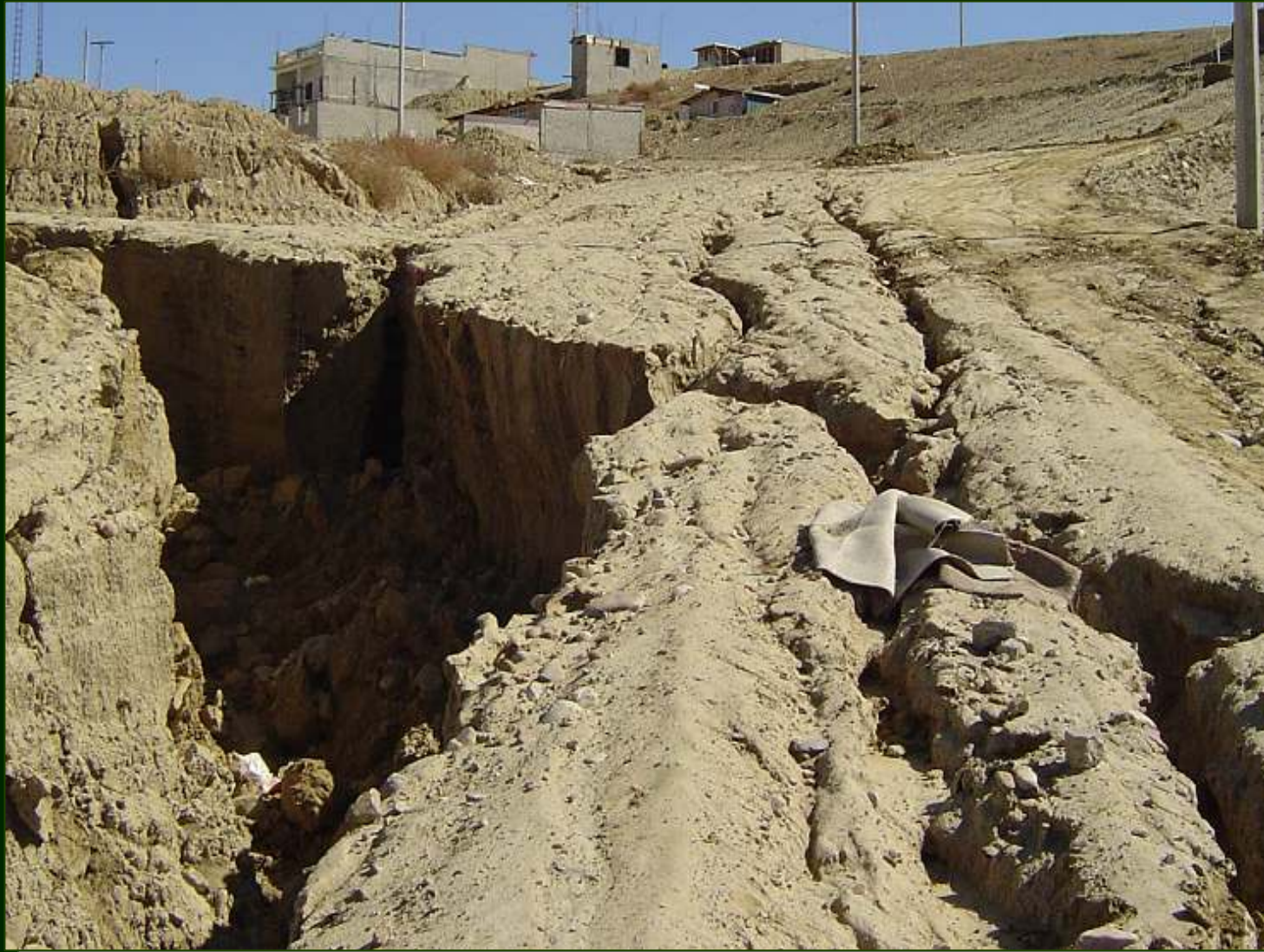
Condiciones del terreno en la Subcuenca de Los Laureles
